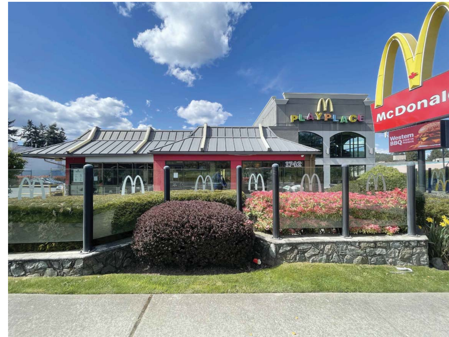
1 EXISTING FRONT VIEW – EAST G003 SCALE: N.T.S.
